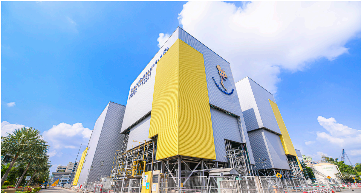
โรงไฟฟ้าพระนครเหนือ
